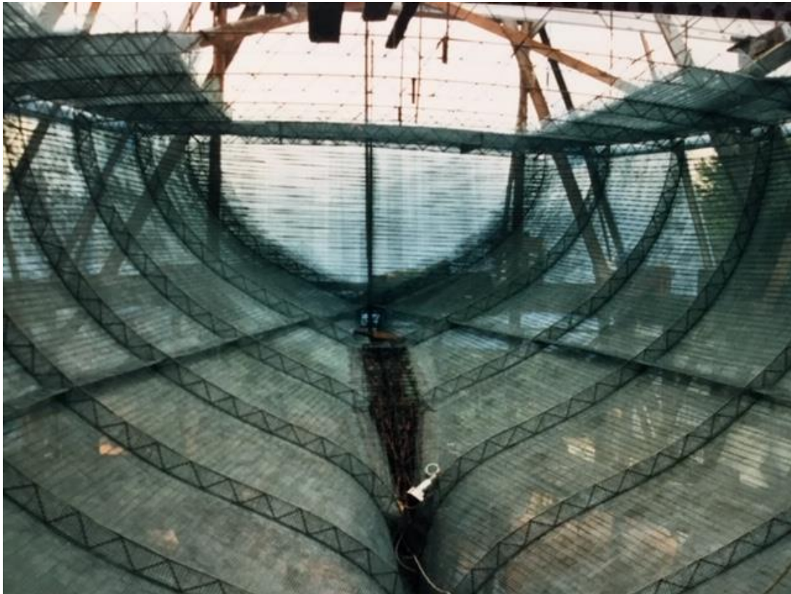
De romp klaar voor het cementeren
