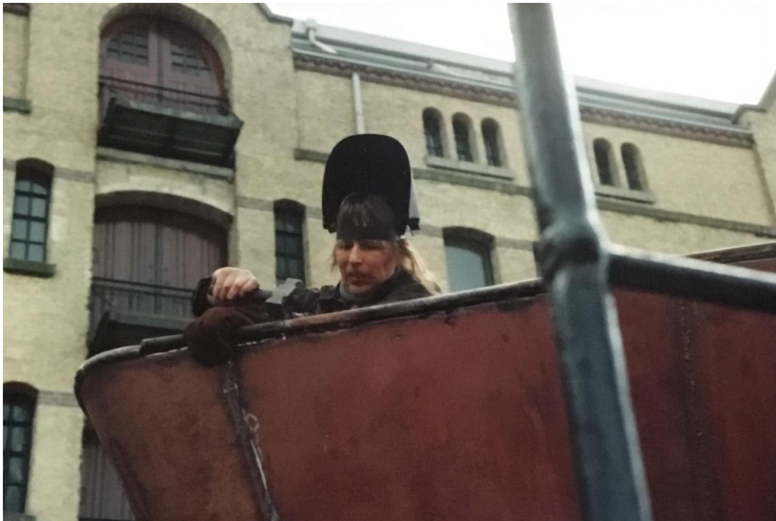
Het aanbrengen van de staalplaten van de verschansing.
