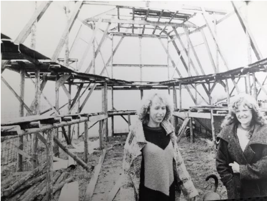
De loods in aanbouw
